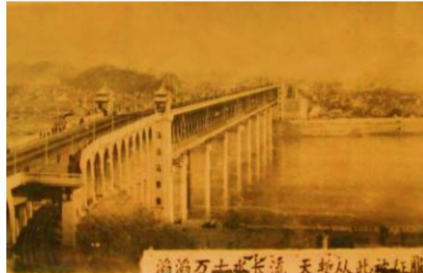
武汉长江大桥
